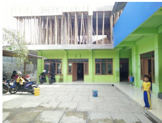
Gambar 7 Kolom Bangunan Sumber: SD PU Muhammadiyah Botok
